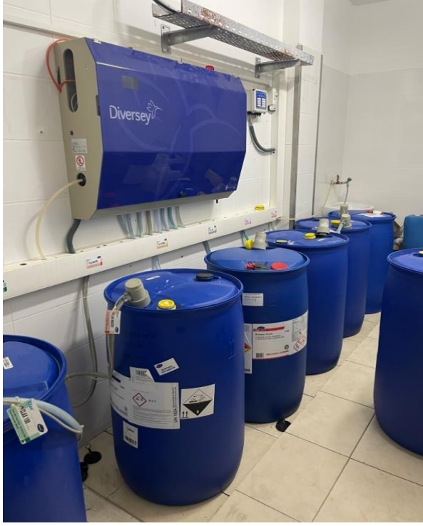
Şekil 16. Çamaşırhane Dozajlama Sistemi ve Refil Dolum Sistemi
