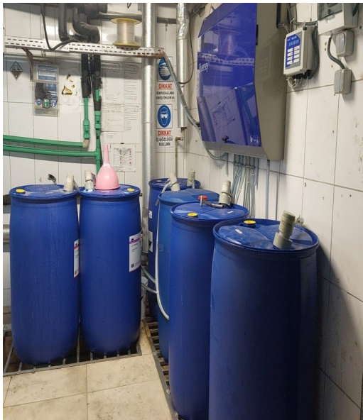
Şekil 18. Çamaşırhane Dozajlama Sistemi ve Refill Dolum Sistemi
