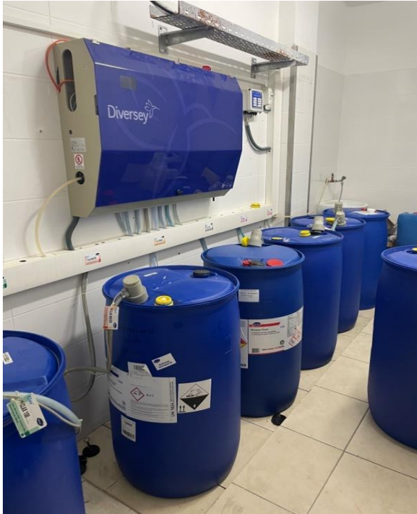
Şekil 18. Çamaşırhane Dozajlama Sistemi ve Refil Dolum Sistemi
